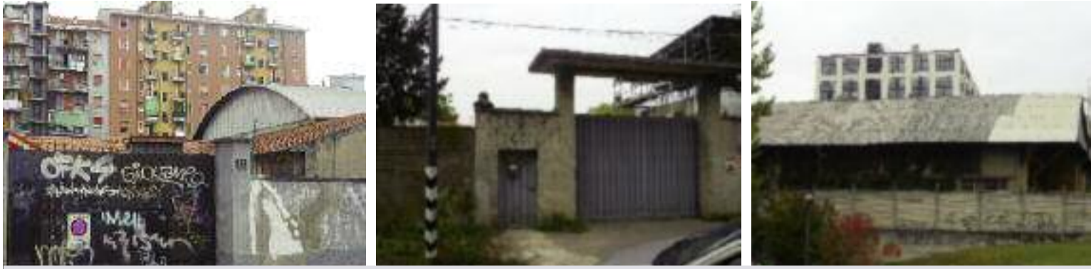
Da sinistra gli edifici di via Bordighera 31, via Campazzino 46 e viale Ortles 58. Tre insediamenti industriali tra i più bisognosi di interventi di bonifica.
